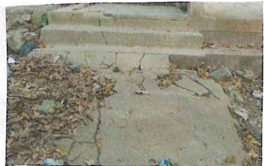
Foto 4: banqueta de concreto
